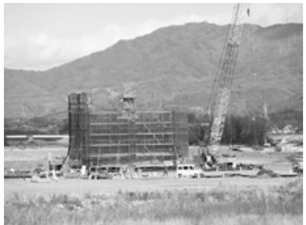
天竜川橋梁工事の写真です。
